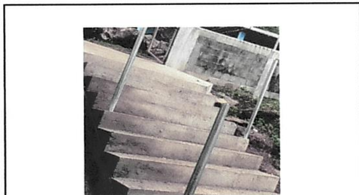
Foto 9: Reparación de gradas de acceso.
